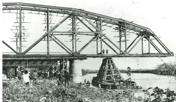
羽幌線天塩川橋梁工事
